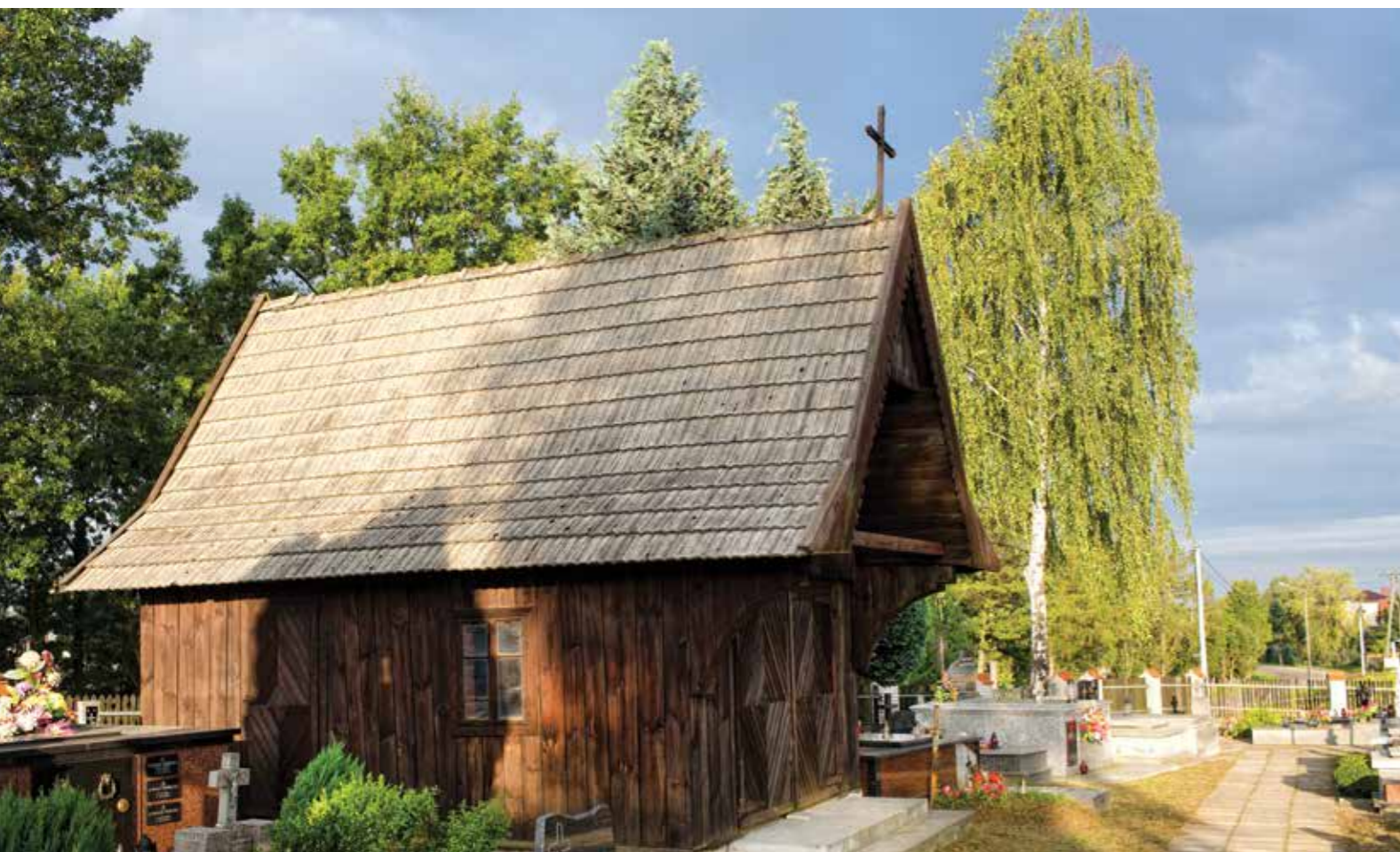
Drewniana kaplica na cmentarzu w Zalasowej / A timber chapel on the cemetery in Zalasowa
